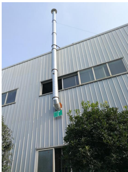
有机废气排气筒
