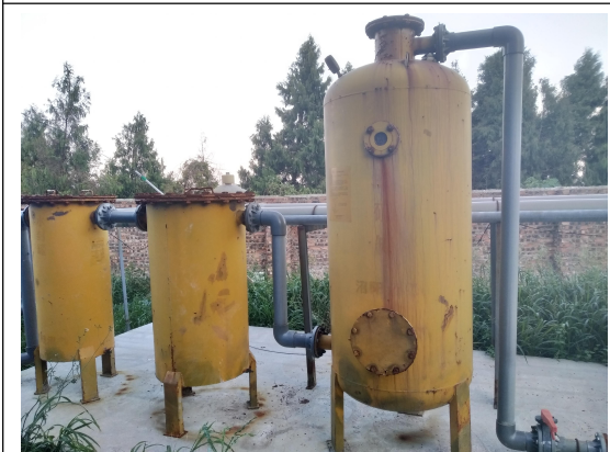
沼气脱硫脱水系统
